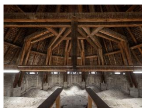
Cathédrale Saint-Pierre de Montpellier : Comble de l'abside vu depuis le chœur © Patrick Tourneboeuf
