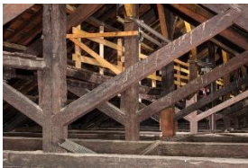
Cathédrale Saint-François-de-Sales de Chambéry : Comble de la nef vers l'est, détail de la charpente © Xavier Spertini
