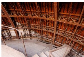
Cathédrale Saint-Pierre de Rennes : Coupole de la croisée du transept, pourtour métallique © Pascal Lemaître
