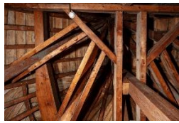
Cathédrale Saint-Pierre de Moutiers : Vue en contre-plongée du comble de l'abside, détail de la charpente © Xavier Spertini
