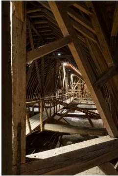
Cathédrale Saint-Gatien de Tours : comble du chœur et de l'abside vu depuis l'ouest © François Lauginie
