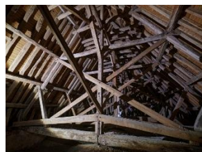
Cathédrale Saint-Gervais-Saint-Protais de Soissons : Comble du bras sud du transept vers le nord © Thomas Jorion
