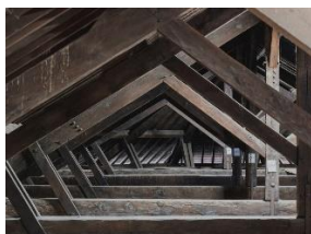
Cathédrale Saint-André de Bordeaux : Comble du chœur et de l'abside vu depuis l'ouest, détail de l'enfilade de fermes côté nord © Alexis Paoli
