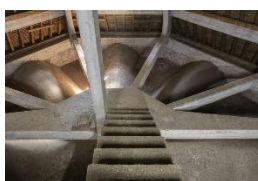
Cathédrale Saint-Dié de Saint-Dié-des-Vosges : Comble de l'abside, détail de la partie basse de la charpente en béton et des extrados © Laurent Kruszyk
