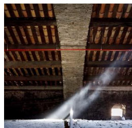
Cathédrale Sainte-Réparate de Nice : Comble de la nef, détail d'une arche vue depuis le nord © Clément Guillaume
