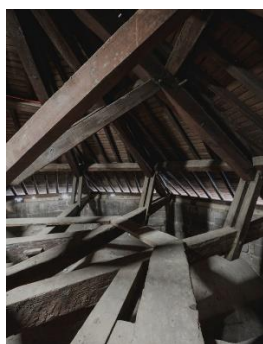
Cathédrale Saint-André de Bordeaux : Comble de l'abside, détail de la partie inférieure de la charpente © Alexis Paoli
