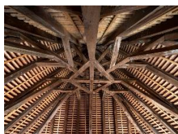
Cathédrale Saint-Étienne de Cahors : Comble du beffroi, vue en contre-plongée de la charpente de la passerelle sud © Patrick Tourneboeuf
