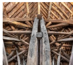
Cathédrale Saint-Cyr-et-Sainte-Julitte de Nevers : Comble de la croisée du transept près du chœur roman, détail d'un poinçon double © Laurent Kruszyk
