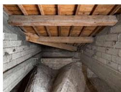
Basilique Saint-Nazaire-et-Saint-Celse de Carcassonne : Comble de la travée droite du chœur en direction du nord, détail de la charpente et des extradoss entre deux cloisonnements © Patrick Tourneboeuf
