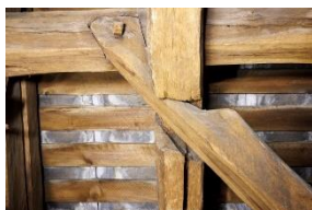
Cathédrale Notre-Dame de Rouen : Section 3 du comble de la nef, détail de la charpente © Pascal Lemaître
