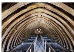
Cathédrale Saint-Corentin de Quimper : Comble nord vu vers la croisée du transept © Pascal Lemaître
