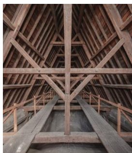
Cathédrale Saint-Étienne de Limoges : Comble du bras sud du transept depuis le sud vers la croisée © Alexis Paoli
